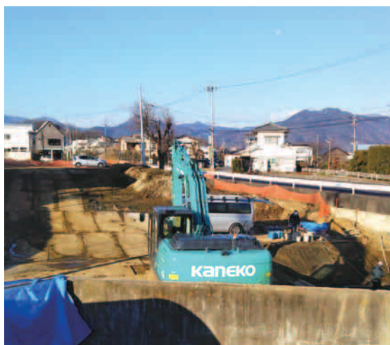
諏訪形の金窓寺川調整池の整備工事作業現場 (大雨時の金窓寺川の水を溜める能力は3,950m³)
