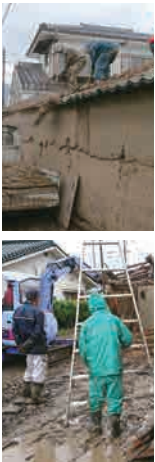
道路沿いの農業用倉庫の撤去作業
