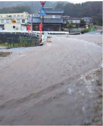
令和元年10月に金窓寺川氾濫をもたらした台風19号。道路に水が押し寄せ濁流となって、家屋10数件が床下浸水しました。
