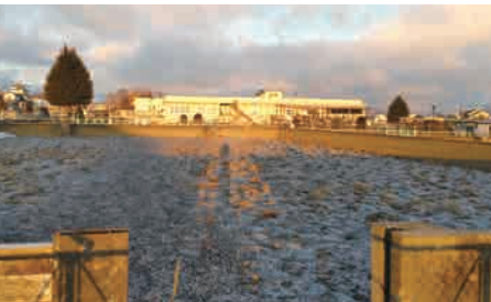
諏訪形地区にある県浄水場。手前は、ろ過に活性炭を使用し取り除いた不純物(泥水)を天日で乾燥させる「天日乾燥池」です。
